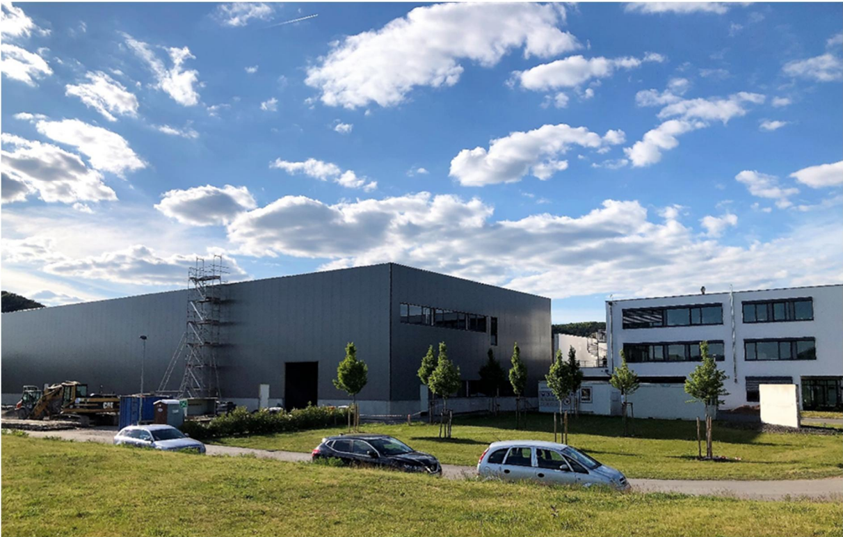
Die entstehende Halle links fügt sich gut ins Ensemble der bestehenden Gebäude ein.
